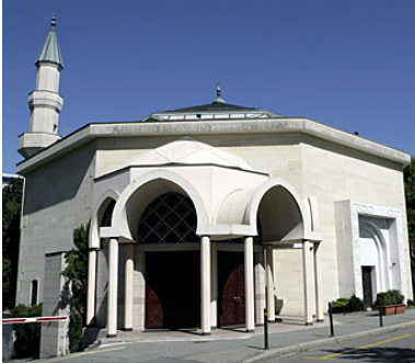
Grand Mosque du Petit-Saconnex, Genf
